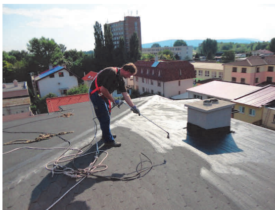
Obr. č. 2 Penetrácia podkladu penetrácia ALP/M
