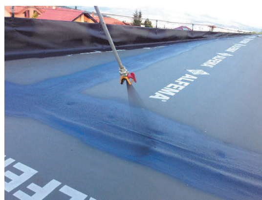
Obr. č. 44 Hydroizolácia nástrekom spojov membrány za pomoci geotextílie a HB500
