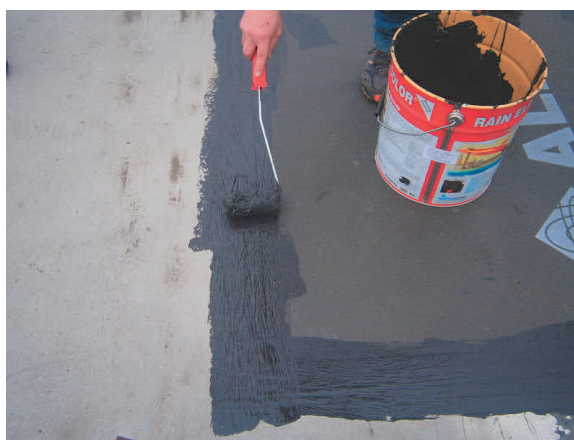
Obr. č. 19 Izolácia ukončenia lokálnej opravy, ukotvenie membrány, zatesnené s ALF G400, pregumované ALF HB500
