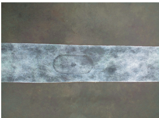
Obr. č. 15 Správne zatesnenie spojov a kotvy ALF páskou
