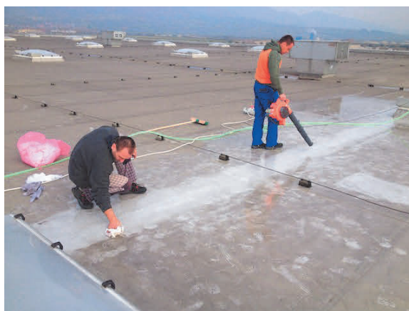
Obr. č. 1 Čistenie podkladu
