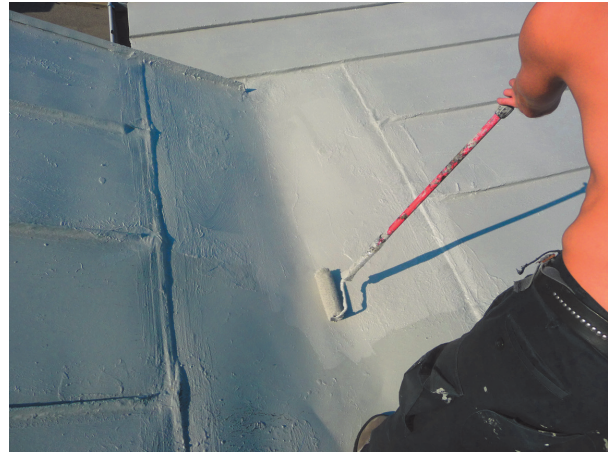
Obr. č. 28 Náter betónového podkladu s ALF HB500 Obr. č. 29 Náter plechovej strechy s ALF TG500
