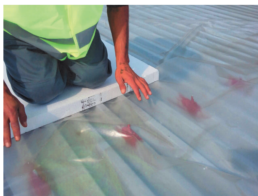
Obr. č. 37 Pokládka separečnej fólie a polistirénu
