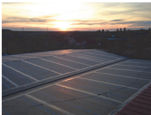
Obr. č. 45 Pohľad na zaizolovanú strechu bez konečného náteru
