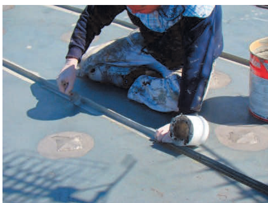
Obr. č. 4 Izolácia spojov plechovej strechy, geotextílie a tekutej gumy ALF TG500
