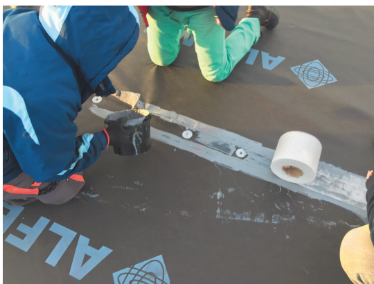
Obr. č. 6 Izolácia spoju membrány, geotextília a ALF FLEX FLOOR v zimnom období
