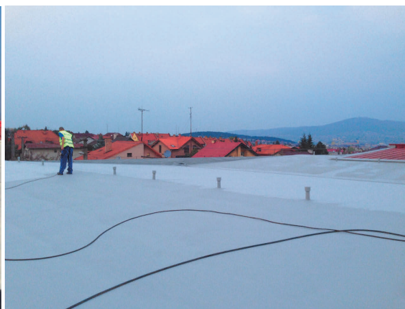
Obr. č. 47 Náhl'ad na konečnú hydroizoláciu
