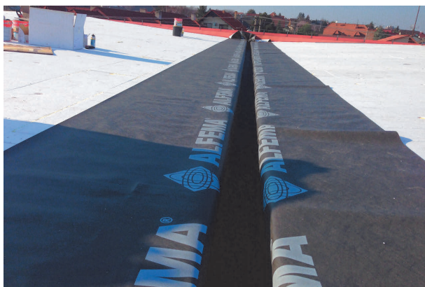
Obr. č. 39 Vystlanie žlabu vodotesnou membránou ALFEMA
