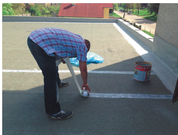
Obr. č. 9 Izolácia spojov asfaltových pásov, ALF páska
