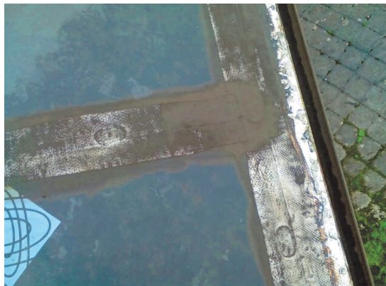
Obr. č. 16 Správne zatesnenie spojov a kotvy, Geotextiliou a ALF HB500
