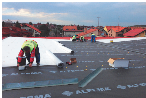
Obr. č. 40 Natiahnutie vodotesnej membrány a jej kotvenie
