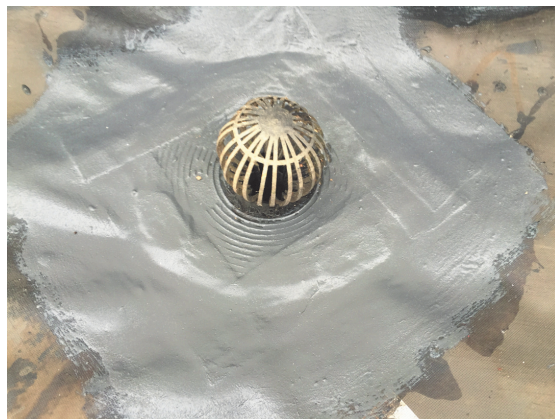
Obr. č. 32 Izolácia vpuste v zimnom období s ALF FLEX FLOOR II.
