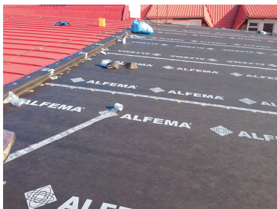
Obr. č. 43 Izolácia spojov membrány s ALF páskou
