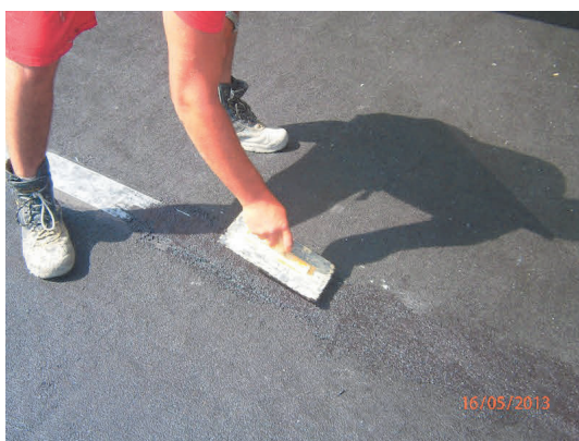
Obr. č. 33 Hydroizolácia spoju s ALF BL100
