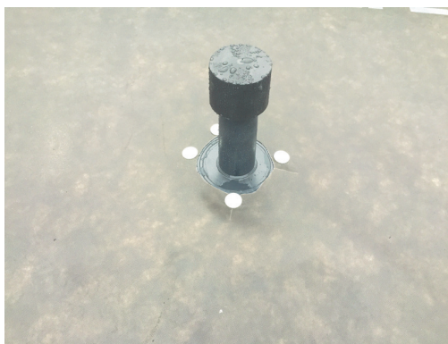
Obr. č. 25 Ukotvenie odvetrávacieho komína Obr. č. 26 zatesnenie odvetrávacieho komína
