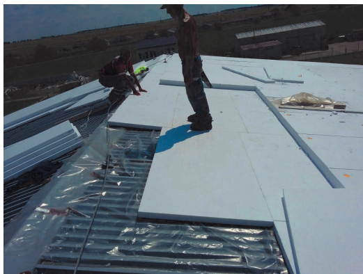
Obr. č. 38 Pokládka tepelnej izolácie s prekladom
