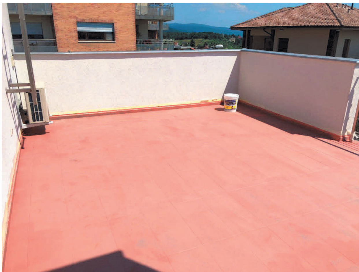
Obr. č. 3 Použitie adhézneho mostíka
