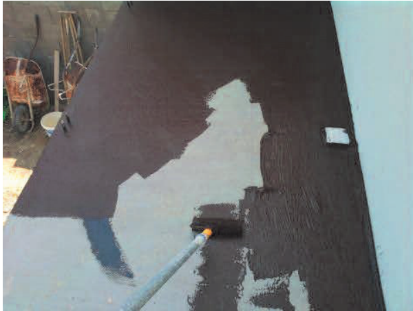
Obr. č. 28 Náter betónového podkladu s ALF HB500 Obr. č. 29 Náter plechovej strechy s ALF TG500
