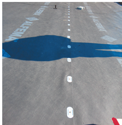
Obr. č. 42 kotvenie každých 25-30cm
