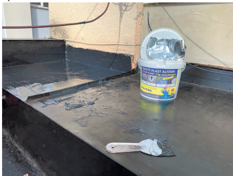
Obr. č. 31 Naaplikovaný ALF FLEX FLOOR II v žľabe počas zimného obdobia
