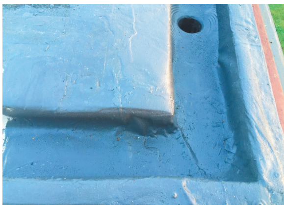
Obr. č. 31 Naaplikovaný ALF FLEX FLOOR II v žľabe počas zimného obdobia
