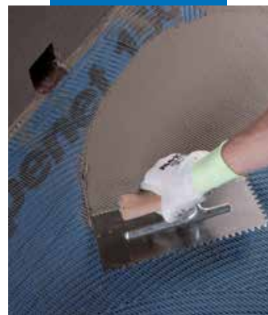
Mapelastic nanášaný na sklotextilnú mriežku Mapenet 150
