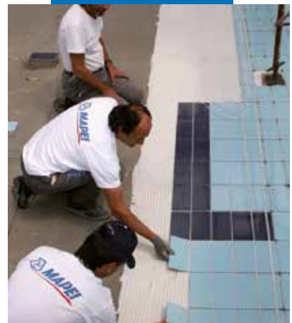
Lepenie dlažby v bazéne na zaizolovaný podklad s Mapelastic
