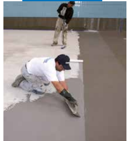
Mapelastic použitý pri izolovaní plaveckého bazéna
