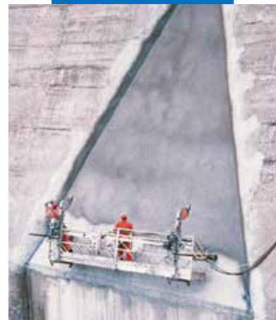
Mapelastic nanášaný nástrekom na vodnej priehrade
