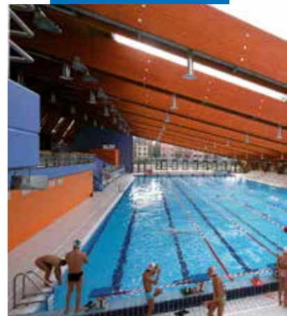
Mapelastic použitý pri izolovaní bazéna v Scarioni Leisure Centro – Miláno – Taliansko
