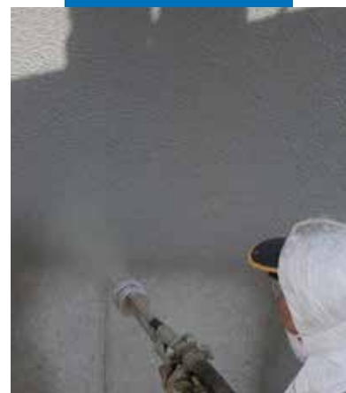
Mapelastic nanášaný nástrekom na viadukte
