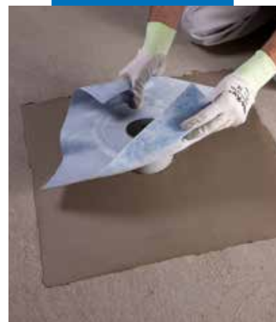
Aplikácia vpuste Drain Vertical na Mapelastic
